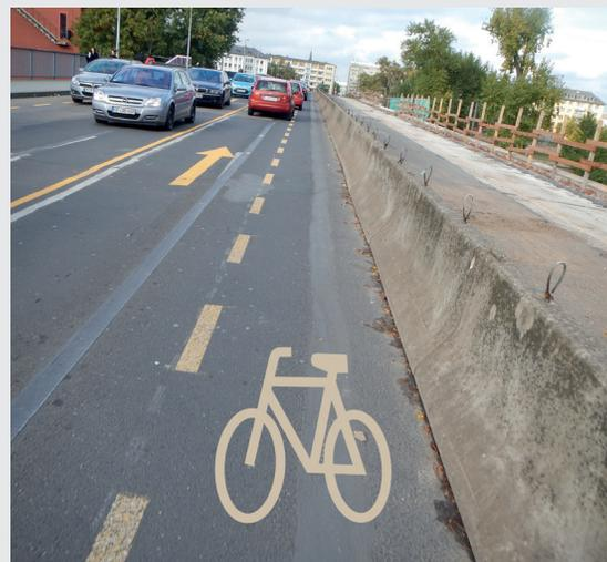
Bild 9 | Schutzstreifen statt Führung in reinem Mischverkehr auf der Fahrbahn
