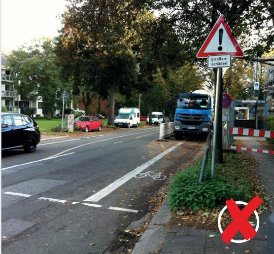
Bild 14 | Arbeitsstelle auf Radfahrstreifen ohne Absicherung
