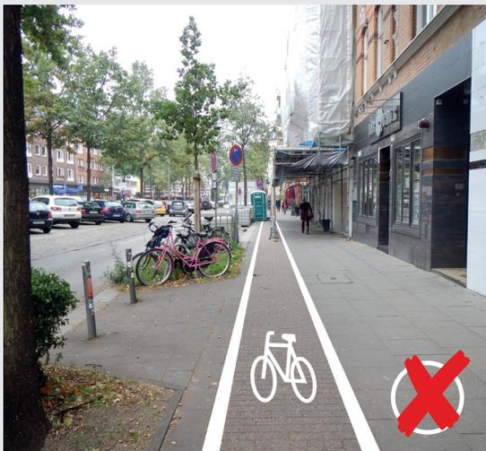
Bild 12 | Gerüst auf Radweg mit schlecht sichtbarer Sicherung
