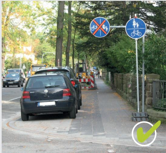
Bild 17 | Klare Kennzeichnung vorübergehend außer Kraft gesetzter Verkehrszeichen
