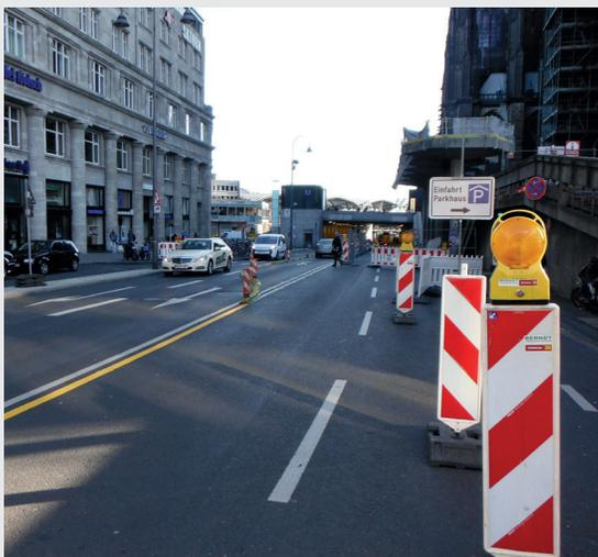
Bild 8 | Führung des Radverkehrs entlang Arbeitsstelle im Mischverkehr bei hoher Kfz-Belastung
