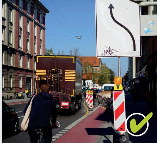
Bild 15 | Arbeitsstelle auf Radfahrstreifen durch Absperrung gesichert
