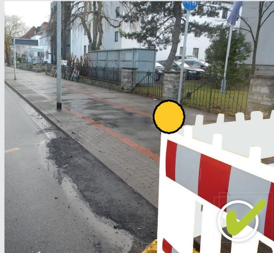
Bild 7 | Anrampung in Form von Asphaltkeil hergestellt
