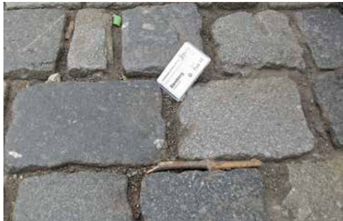
Fußgängerzone mit unverfugten Pflastersteinen
